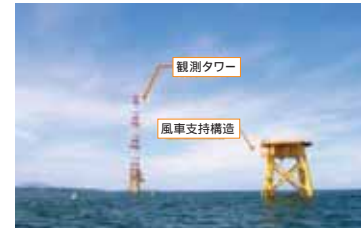
福岡県北九州市沖の風況観測タワーと風車支持構造
