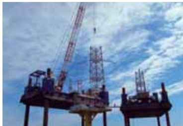
風況観測タワー建設の様子(銚子沖)
