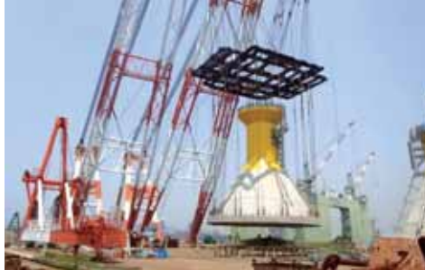
完成した基礎は、FD船に積込・運搬し、起重機船で吊り下げて所定の場所に設置します
