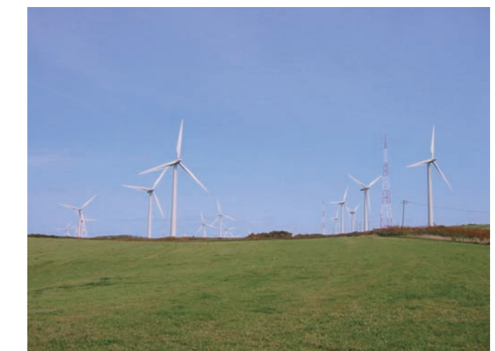
苫前グリーンヒルウィンドファーム Tomamae Green Wind Farm
